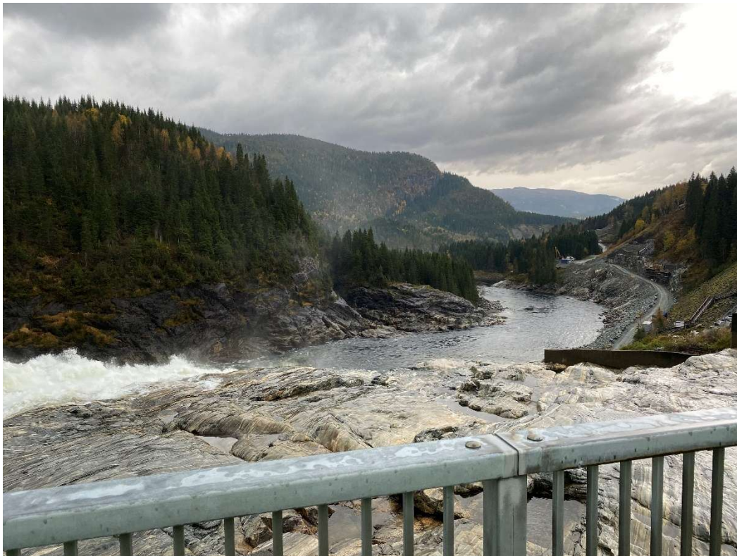
Bilde 5 Nye nedre Fiskumfoss kraftstasjon
