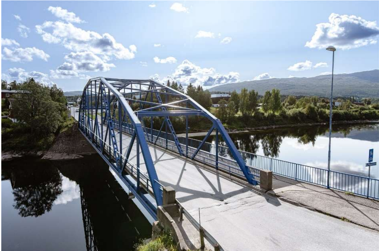
Bilde 1 Grongbrua inn til Medjå
